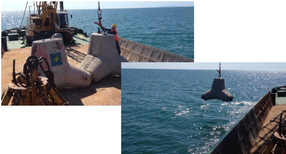
Fig. 12) Esempio di tetrapode installato durante il progetto Life Poseidone
